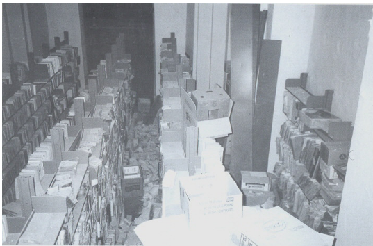
La Biblioteca dopo il terremoto del 1997
